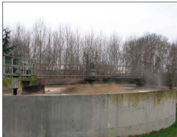
Bac de décantation\* d'une station d'épuration
